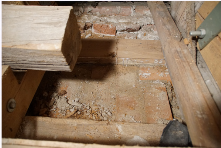
Mauerlatte fertig
