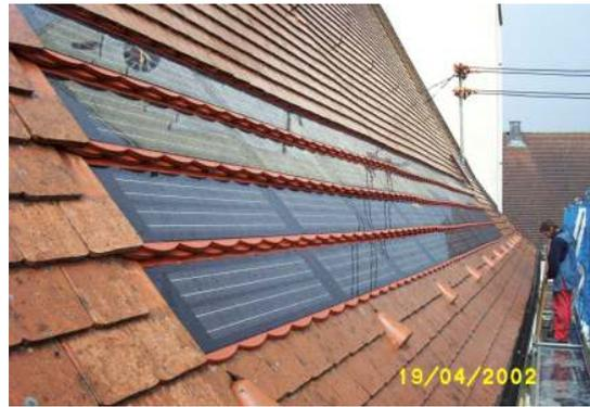
Somit konnte mit dem Bau der Anlage am 19. April 2002 begonnen werden. In Zusammenarbeit mit der Firma System Sonne und mit viel Engagement einiger Kirchengemeinde Mitglieder wurde die Photovoltaik-Anlage, mit einer Spitzenleistung von 1,12 kWp, aufgebaut und am späten Nachmittag sofort in Betrieb genommen werden. Seither liefert diese Anlage ununterbrochen und störungsfrei, jährlich ca. 1000 kWh umweltfreundliche elektrische Energie an das öffentliche Stromnetz.
